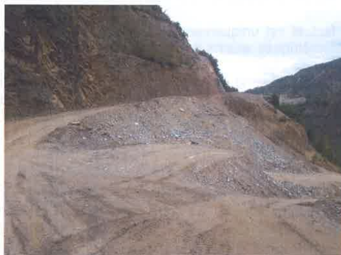
Photographie de la plateforme investiguée
